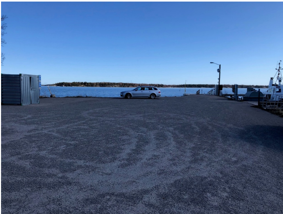
Foto: Yttre kajen i Rävsnäs. Bild från 2021.
