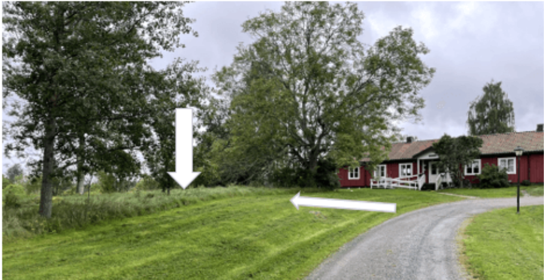
Figur 33: Vertikal pil visar platsen för tänkt placering av byggrätt med angöring från befintlig väg, horisontell pil. Bilden tagen med det södra logihuset (3 c) i fonden. Foto HoP Arkitekter.
