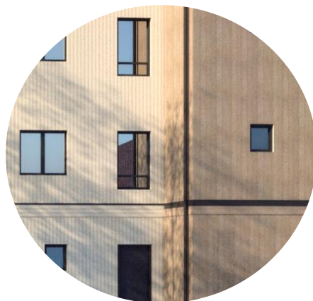
Figur 23 - Inzoomning på fasad där träpanel byter riktning och markerar bottenvåningen (A-sidan, 2024)
