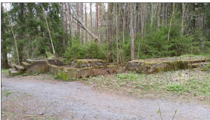
Foto 3. Husgrund i betong belägen i områdets norra del.
