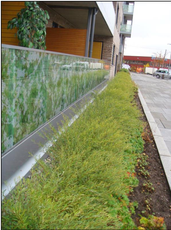
Figur 18. Exempel på rain garden. Bild: Norconsult
