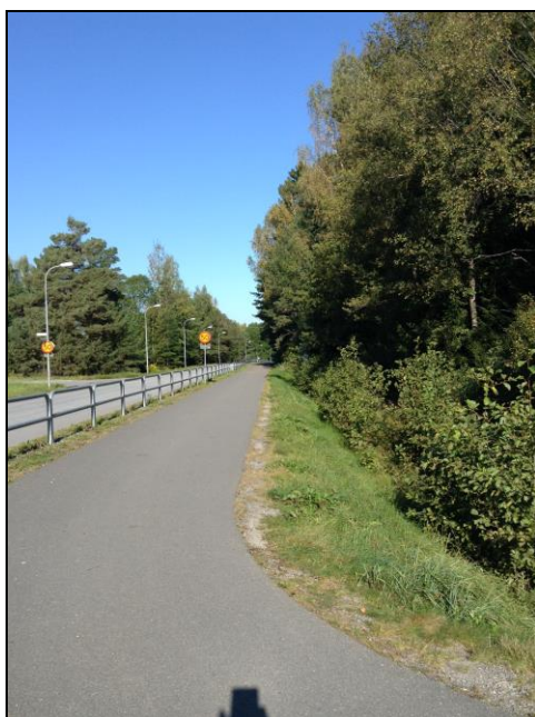
Figur 4. Väg diket vid gång- och cykelbanan vid Rånäsvägen.
