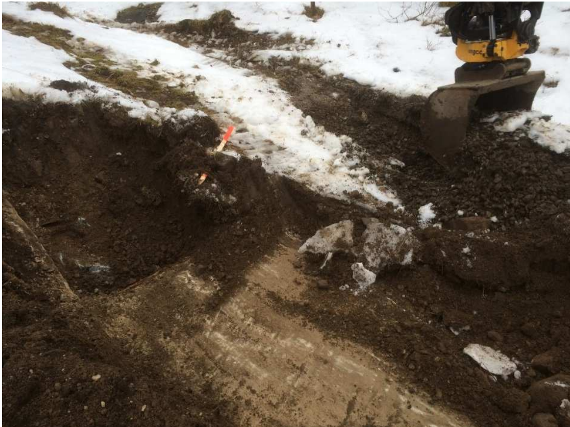
Bild 8. Vid provpunkt 17AF016A påträffades fyllnadsmaterial bestående av grus och sten samt ett fundament på 0,5 m djup.
