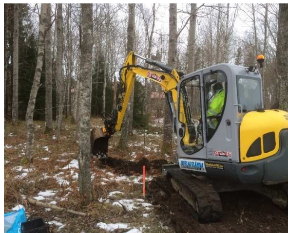
Bild 2. I provpunkt 17AF011B blev det grävstopp vid 1,4 m djup.
