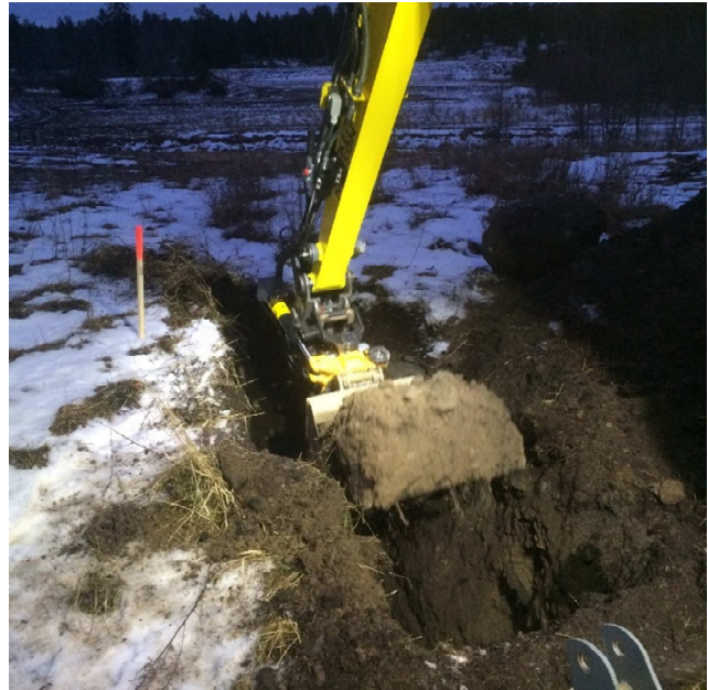
Bild 4. Provpunkt 17AF015B. Grusig, sandig och lerig morän påträffades mellan 0,5-2 m. Vid 2,2 m blev det grävstopp pga berg.
