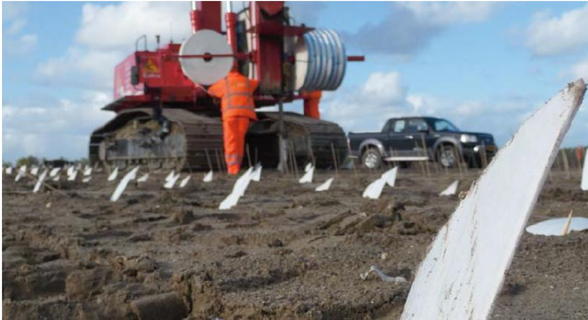
Figur 10. Installerade banddräner i förgrunden. I bakgrunden syns maskinen som installerar dränerna. Bild från Geotechnics BV.
