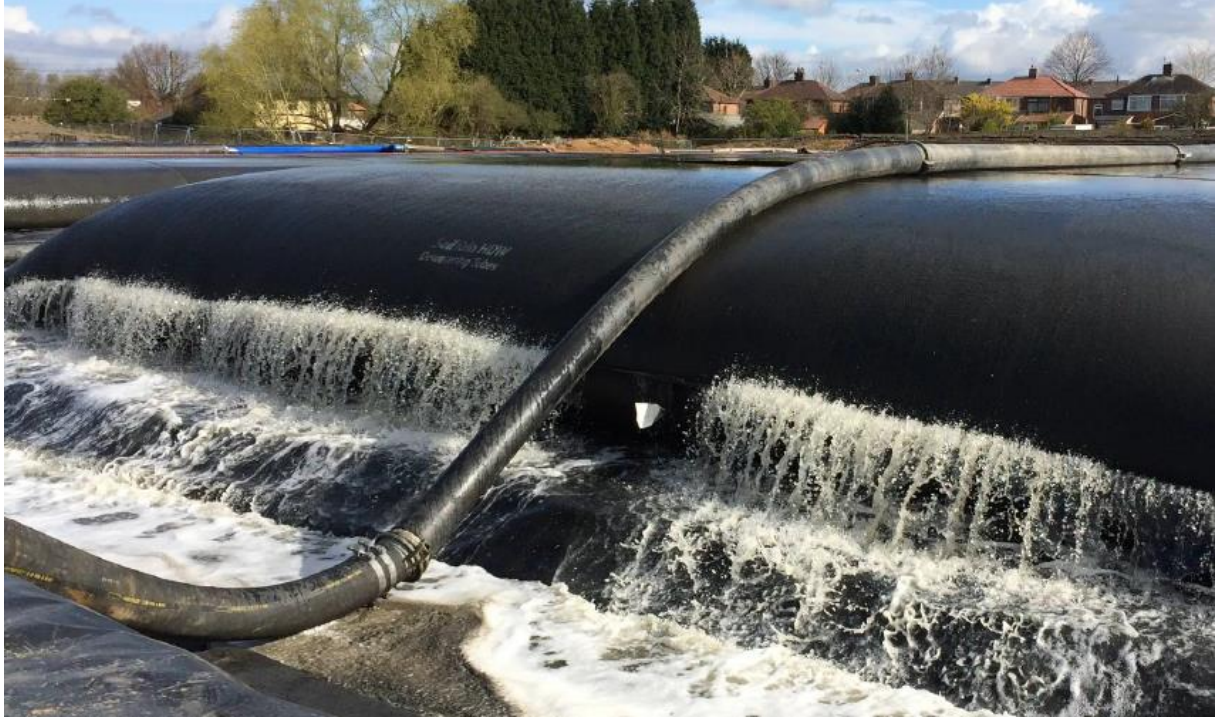
Figur 11. Bild på geotub som fyllts med jordmaterial. Bild från Huesker.
